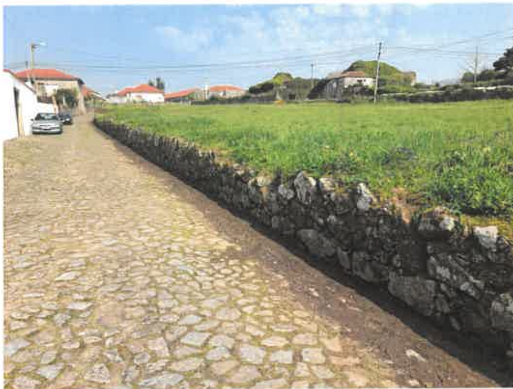
Imagem 5 – Limpeza de canais Rua Senhora do Pilar
