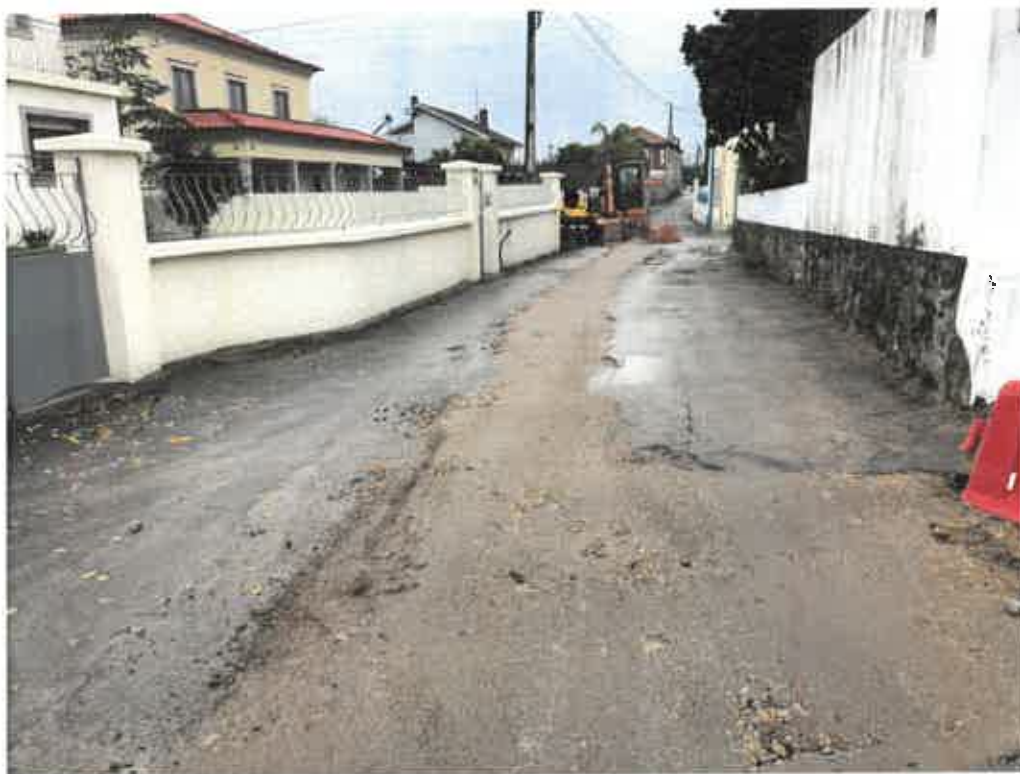
Imagem 56 – Rua de Portuzelo rede de água
