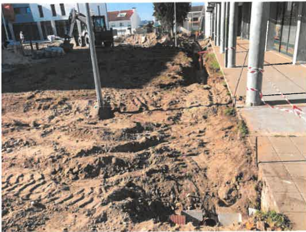
Imagem 48 – Rede de Saneamento e Pluviais na Junta
