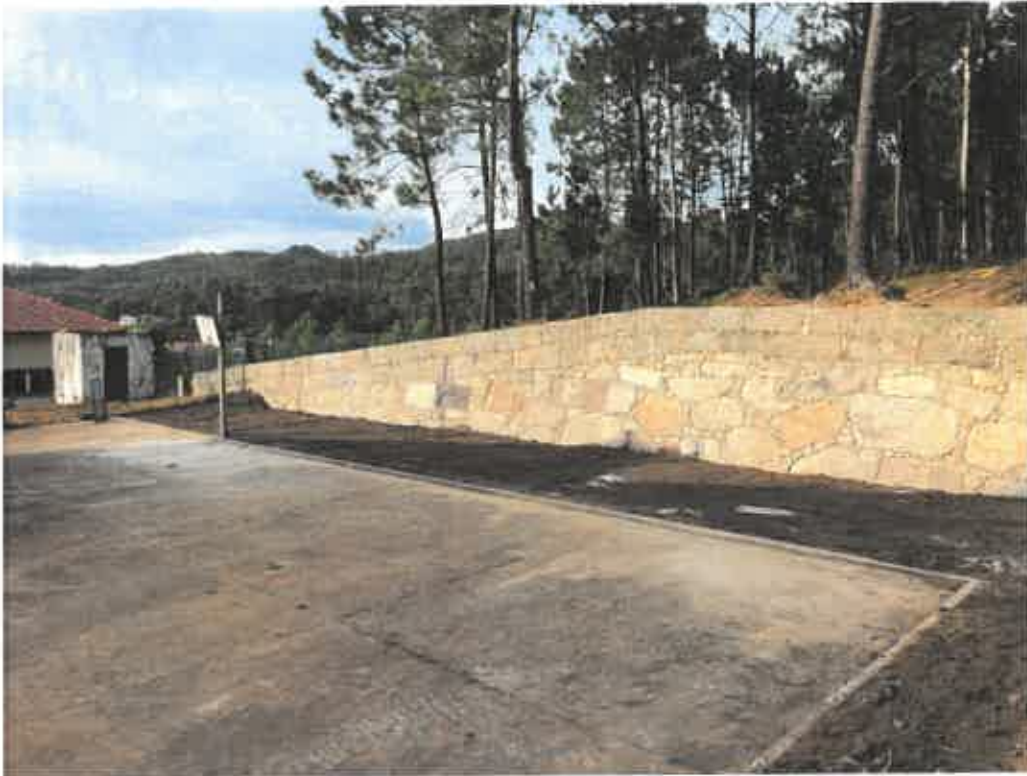
Imagem 47 – Muro Escola de Samonde
